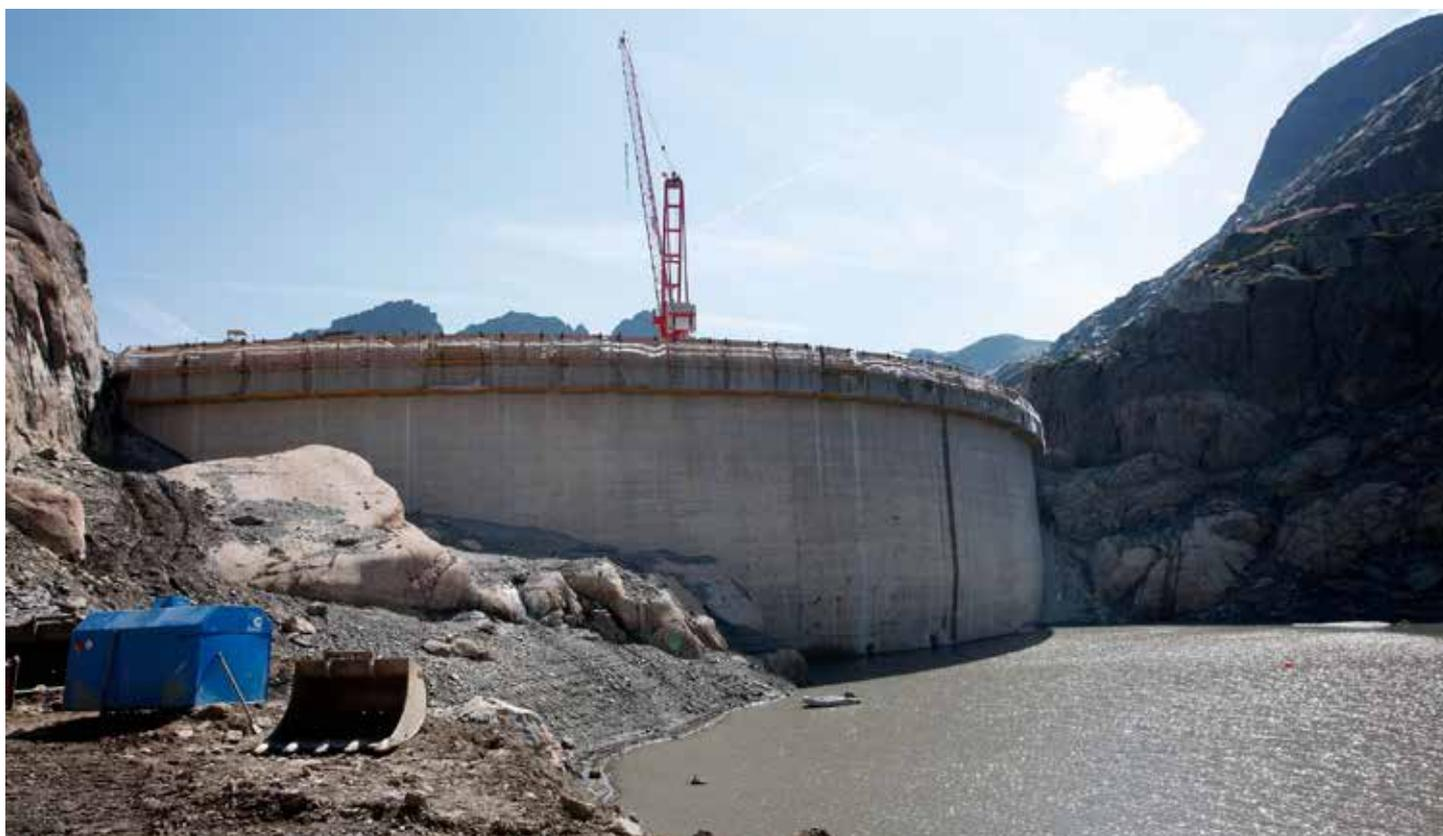
**Surélévation du barrage de Vieux-Emosson, dans le cadre de la construction du nouvel aménagement de pompage-turbinage de Nant de Drance.**
