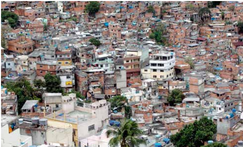
Blick in die Favelas in Rio de Janeiro
